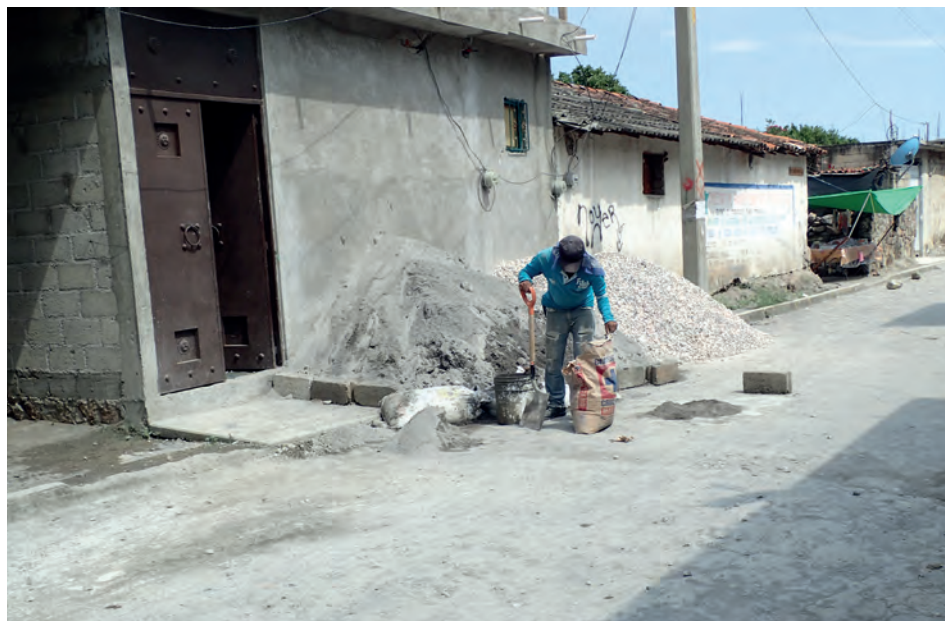
Figura 64. Albañil preparando la mezcla. Foto: Santana, 2019.
