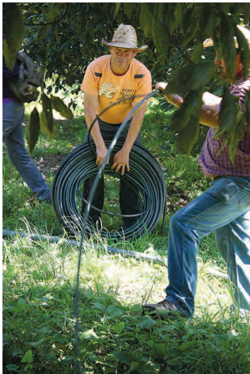
Foto 121. Colocación de mangueras secundarias. Tetela del Volcán, Tetela del Volcán. 2013.
