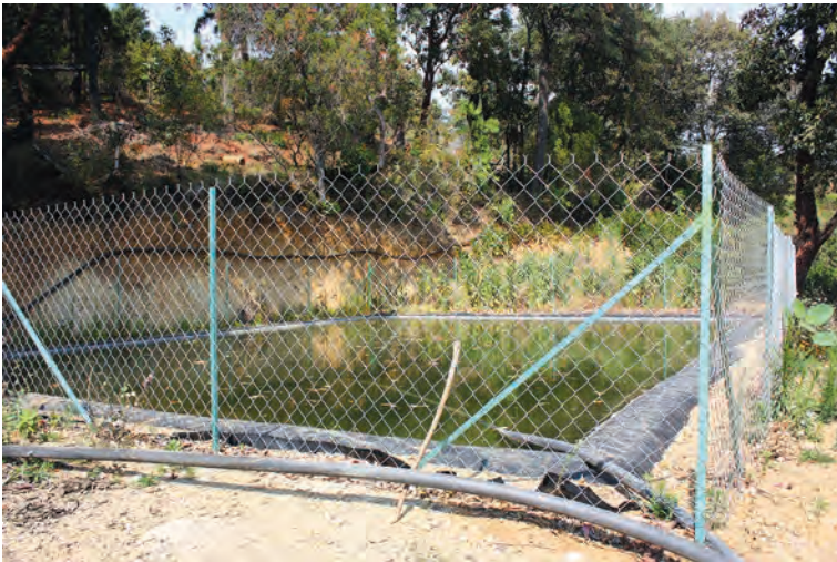
Foto 22. Hoya para almacenamiento de agua de riego. Hueyapan, Tetela del Volcán. 2013.
