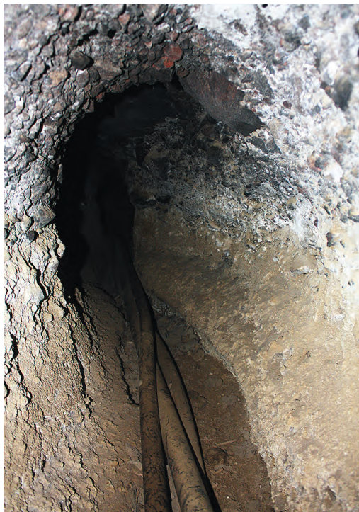
Foto 118. Túneles para el paso de canales, hoy con mangueras. Hueyapan, Tetela del Volcán. 2015.
