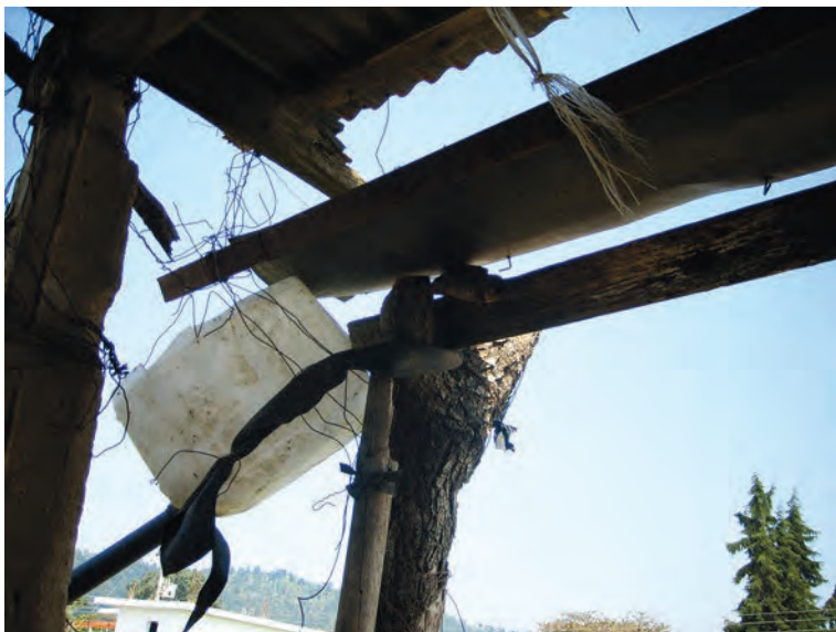
Foto 8. Sistema artesanal de captación de agua lluvia. Villa Nicolás Zapata, Totolapan. 2011.
