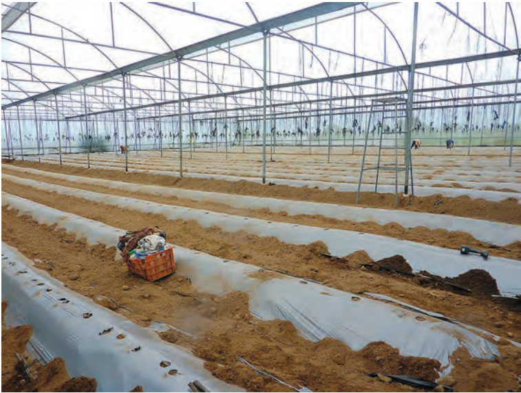
Foto 66. Invernadero en construcción. Achichipico, Yecapixtla. 2015.
