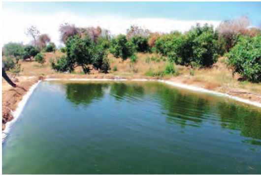
Foto 45. Hoya de almacenamiento de agua para riego. Tetela del Volcán, Tetela del Volcán. 2013.
