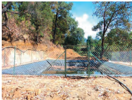
Foto 24. Hoya para almacenamiento de agua de riego. Hueyapan, Tetela del Volcán. 2013.
