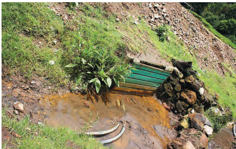
Foto 107. Caja de captación de agua en barranca de Duraznotla. Hueyapan, Tetela del Volcán. 2011.
