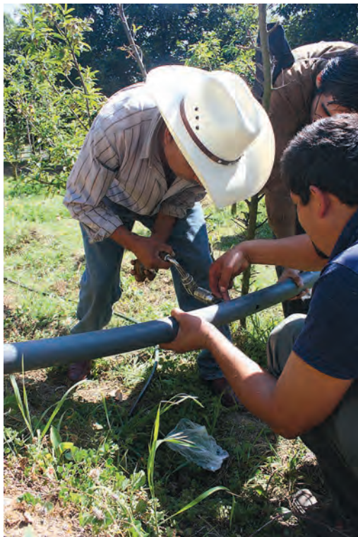
Foto 123. Perforando la manguera principal. Tetela del Volcán, Tetela del Volcán. 2013.
